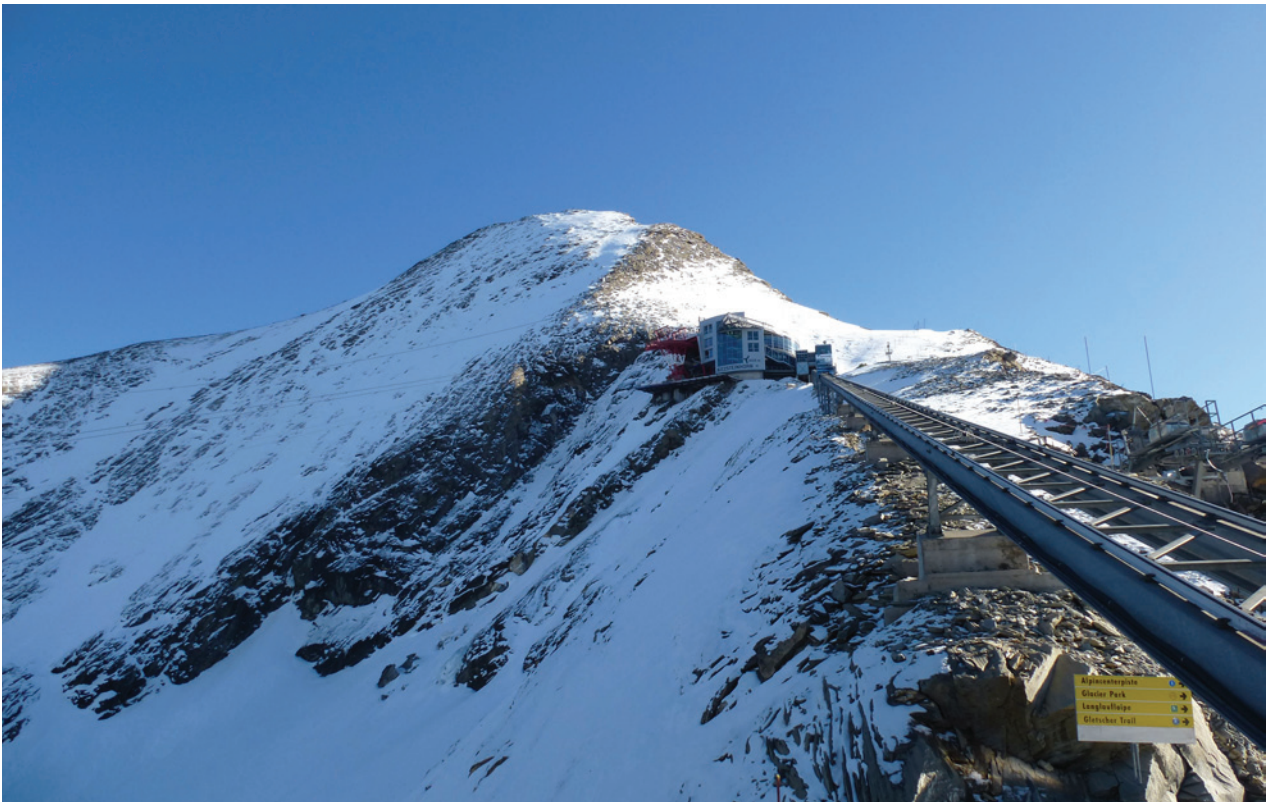
Abb. 2: Die Bergstation der Seilbahn auf das Kitzsteinhorn (3029 m, Glocknergruppe, Salzburg) wurde auf Fels errichtet, der großteils unter Permafrost-Bedingungen steht (Foto: Lieb)
